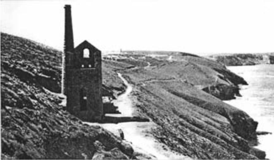
*Abb. 22: Pumpenhaus von 1872 des 210 m tiefen Towanwroath Schachts. Gehört zur Grube Wheal Coates an der Nordküste von Cornwall, westlich von St. Agnes*
