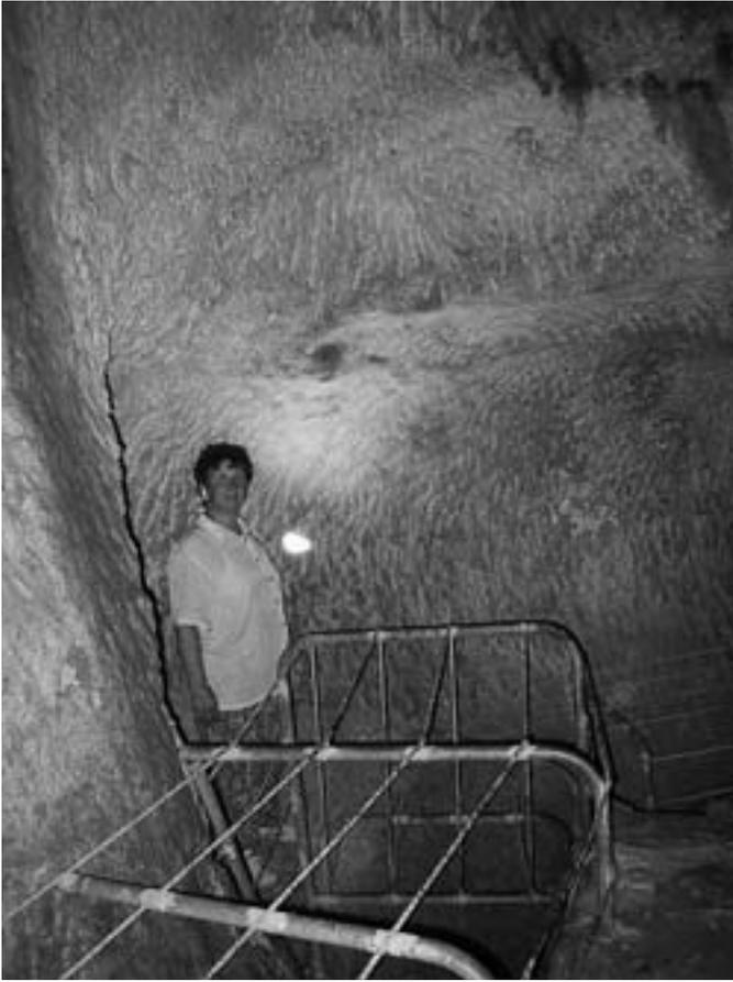
*Abb. 9: Der rechtwinklige Treffpunkt. Nach rechts geht der Südstollen weiter. Deutlich sichtbar sind der vertikale Absatz von 50 cm und die Schräm Spuren.*
