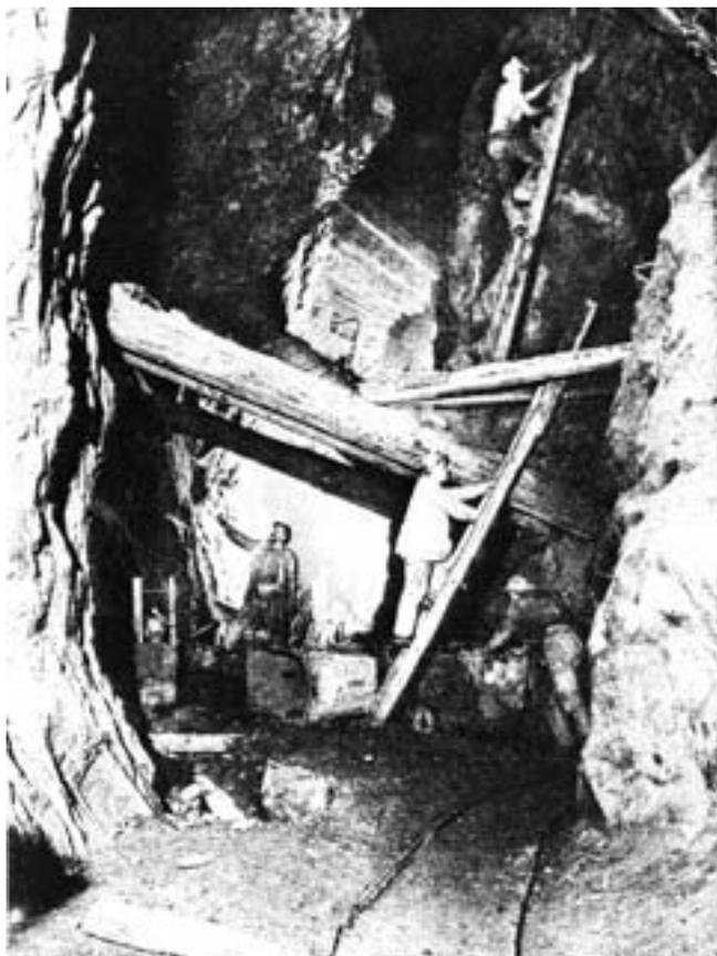
Abb. 17 Weite, nur mit Stempeln und Balkenbühnen verstrebt Gangpartie oberhalb East Pool's 330 m Sohle, um 1895. Bis 90 m oberhalb und 110 m unterhalb dieser Sohle wurde der Erzgang vollständig abgebaut, so dass riesige Höhlungen entstanden. Trotz des Einbaus von Stahlbetonpfeilern und – Bögen kollabierten diese Gangpartien im Mai 1921, was zur Schliessung der Grube führte.
