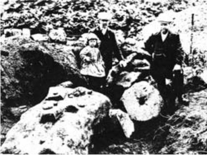
*Abb. 20: Mittelalterliche Steinmühlen (aus Granit) zum Stampfen und Reiben von Zinnerz (Vorrass Mine bei St. Erth nabe Hayle)*
