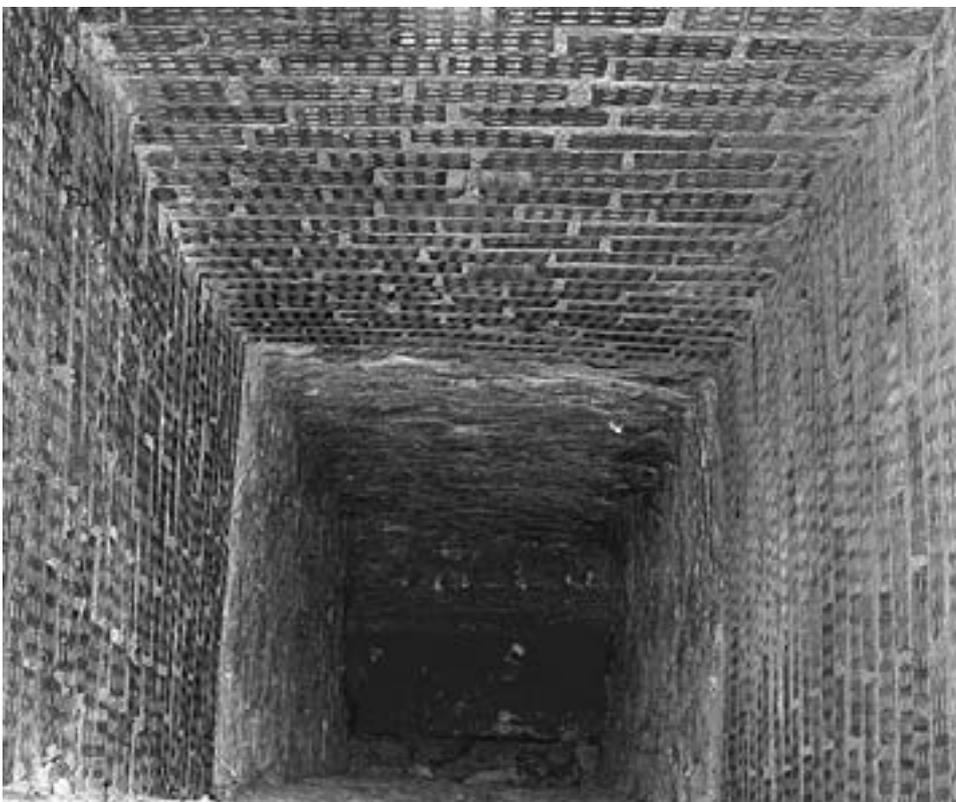
*Abb. 5: Der zweitletzte Schacht: Oben mit Ziegelsteinen rekonstruiert, unten präzise in den Felsen gehauen und zuunterst der Leitungsgraben*
