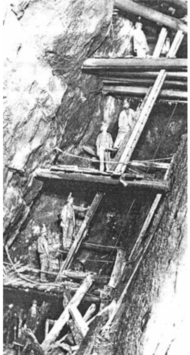
*Abb. 21: Dolcoath Mine, 1892: Der berühmte Fabrikunstschaft (man engine) auf Höhe der 430 m Sohle. Zu dieser Zeit war die Fabrung bereits seit mehr als 25 Jahren in Betrieb, wobei die Verzimmerung in der feuchtwarmen Grubenluft rasch vermoderte, was häufige Reparaturen der Holzplattformen erforderte – die Balkenreste liess man im Schacht liegen (Foto J. C. Burrow, Truro Museum Coll.)*
