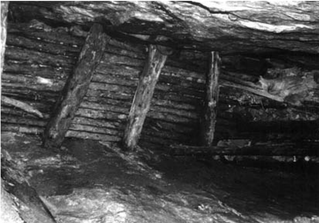
Abb. 4 Mit Zimmerung abgestützter Versatz in den Abbaukavernen zwischen Stollenniveau Rebasso und Metacalcina (Foto St. Wanner 1986 vor dem Einsturz 1994)
