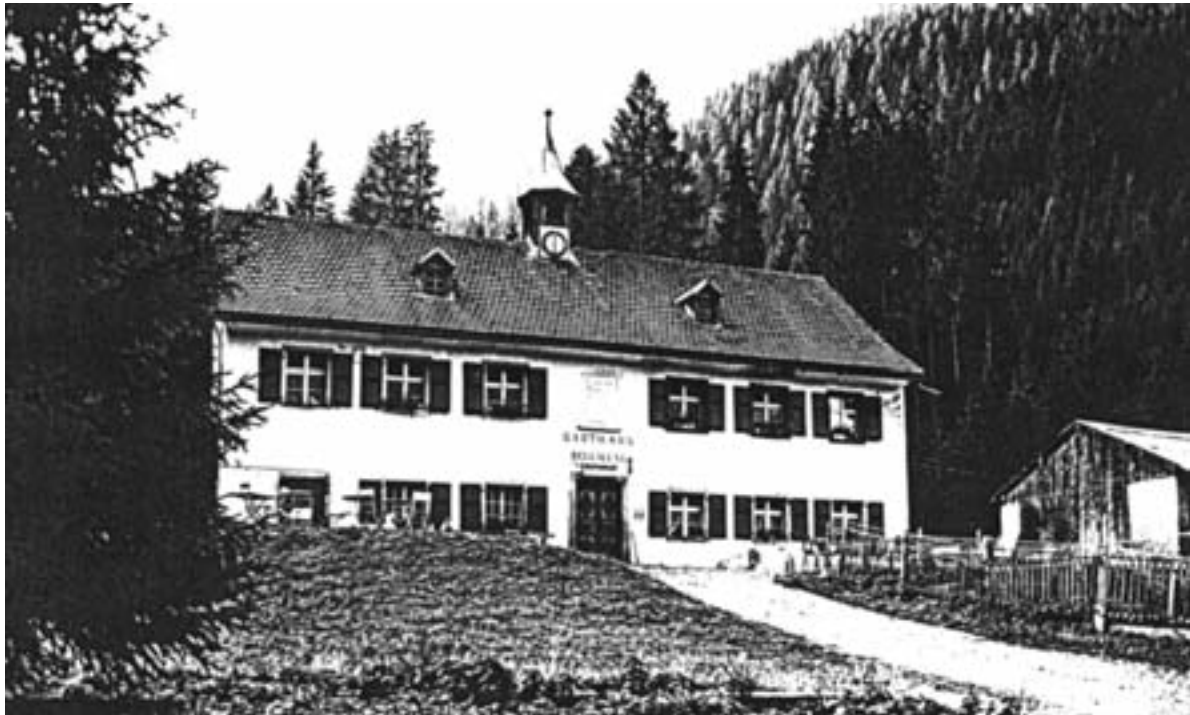
Abb 1 Verwaltungs- und Knappenhaus in Bellaluna mit dem markanten Dachreiter. In diesem Haus führte Paula Roth die Gaststätte. (Foto Gensetter)
