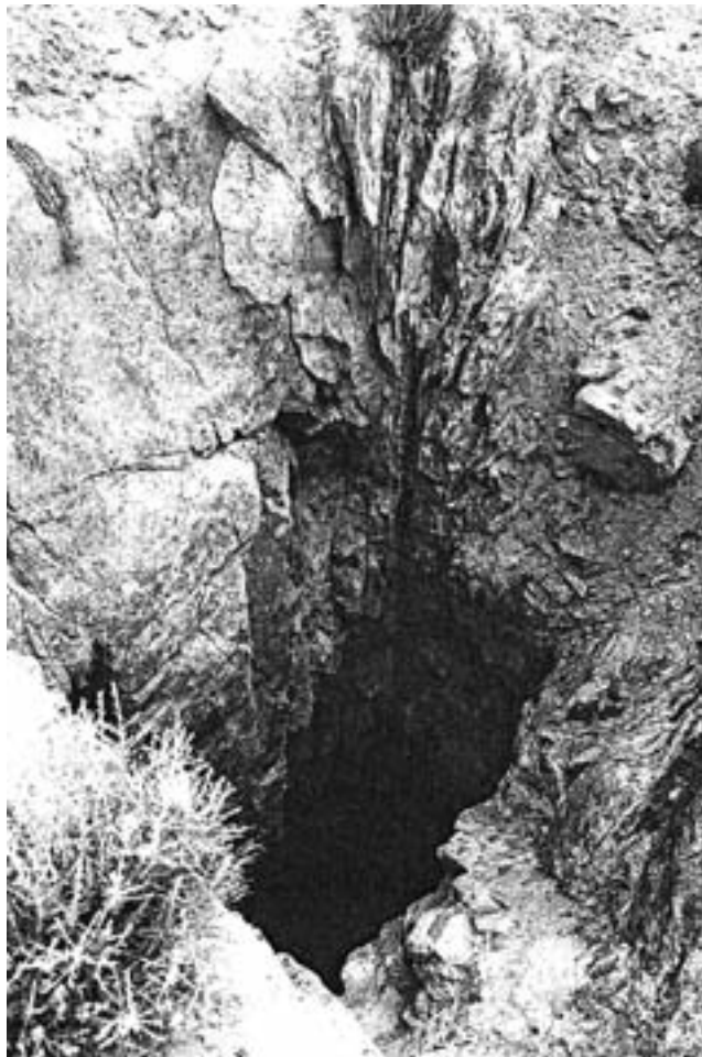
Abb 13 Karnab. in der Wand eines rezenten Wetterschachtes ist der Erzgang sichtbar (aus Eurasia Antiqua)
