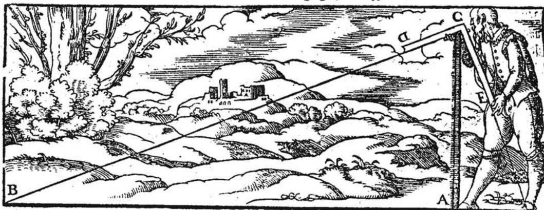
Abb. 3 Höhensatz zur Bestimmung der Länge des Hypothenusenabschnittes AB. Der rechte Winkel wird mit dem Winckelhacken gebildet (siehe Text)
