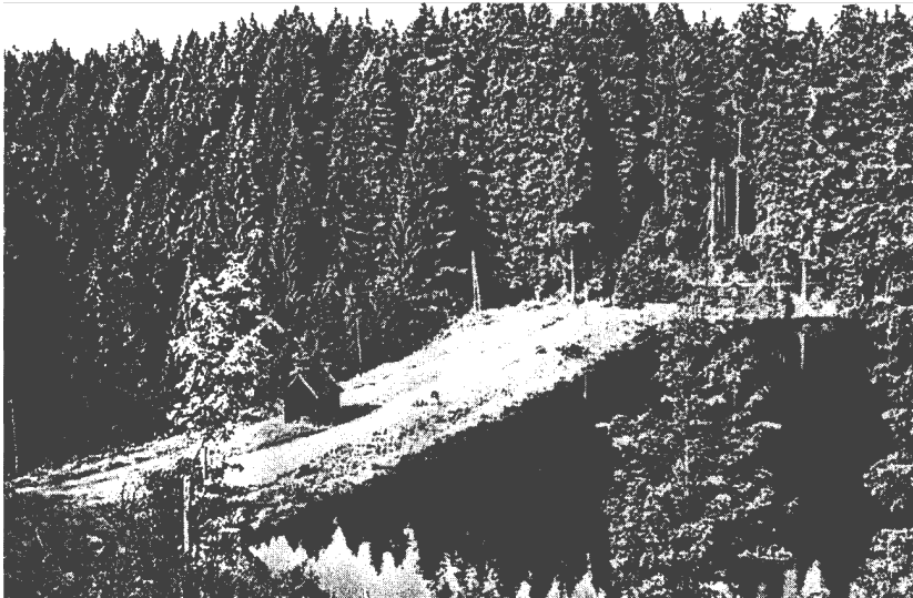
Abb. 10 Der Untere Schalker Teich. Die breite Dammkrone und der Striegelschacht weisen ihn als einen Damm der Neuen Bauweise aus
