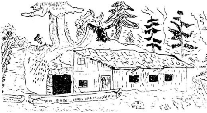
Abb. 7 Ansicht eines Teiles der Bauten aus der 3. Bergbauperiode 1856 - 1867 im Mai 1989 am Eingang der Grube "Tschengels" (2)
