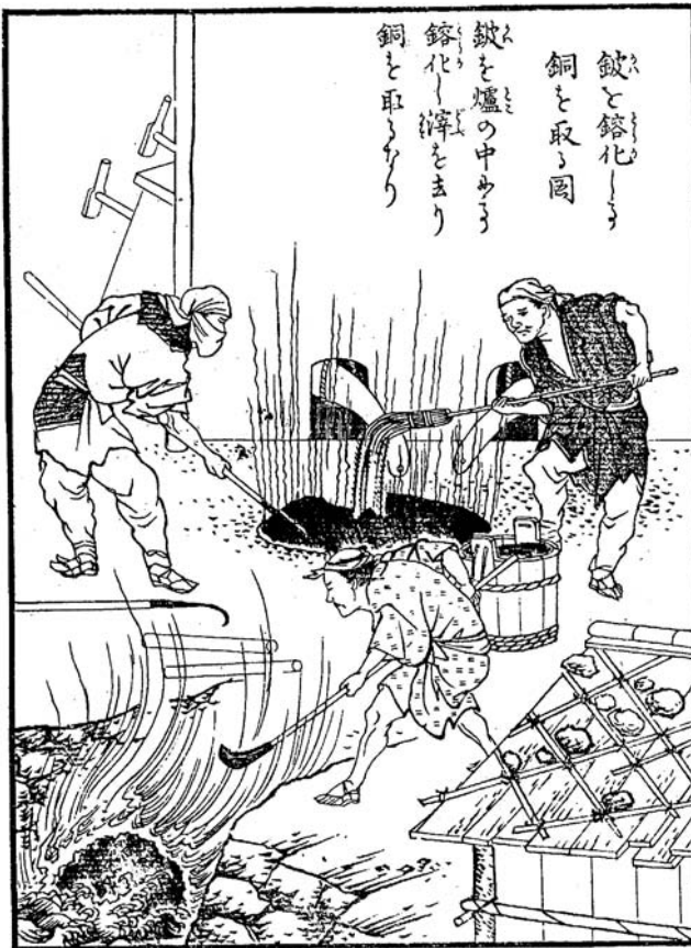
Abb. 8 Darstellung des Steinschmelzens und der Gewinnung von Kupfer: Hier findet die Umwandlung des Kupfersteins zu metallischem Kupfer statt, der Mabuki-Prozess. Der Kupferstein wird, in oxidierender Atmosphäre durch Aufblasen von Luft in metallisches Kupfer umgewandelt. Drei Arbeiter sind damit beschäftigt, aus dem Ofen die Schlacke abziehen. Diese wird mittels eines Strohbesens mit Wasser besprengt, mit einem Hacken abgezogen und in ein Wasserbecken geworfen. Erkennbar ist ein Kasten-gebläse mit Düsen als Luftzufuhr.
