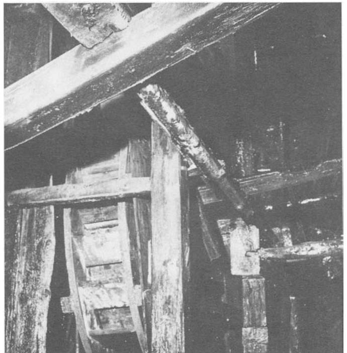
Silberberg: Schöpfrad im Andreasstollen, 3.60m Durchmesser. Das Wasser wurde im Förderschacht durch Holzteucheln zugeführt. Das Schöpfrad diente auch als Förderkraft für das Erz.
