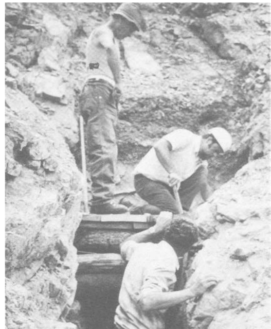
Abb. 7) Arbeiten am Stolleneingang Obermadlain
