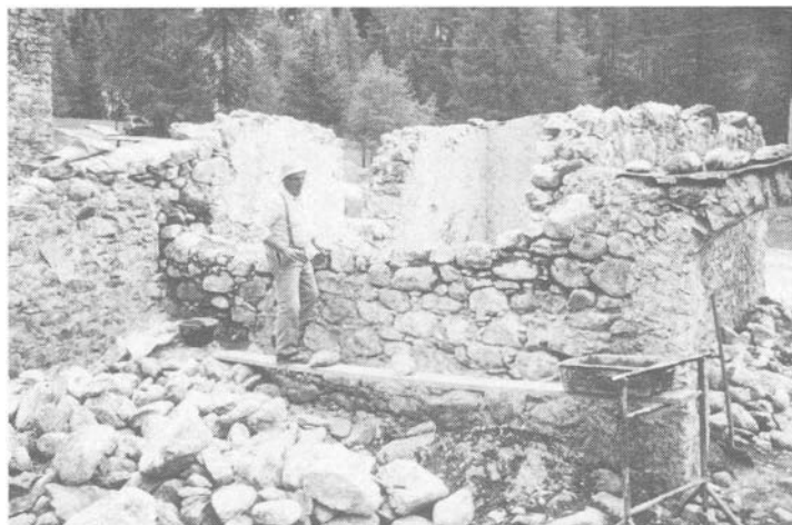
Abb. 8) Maurerarbeiten am Schmelzgebäude
