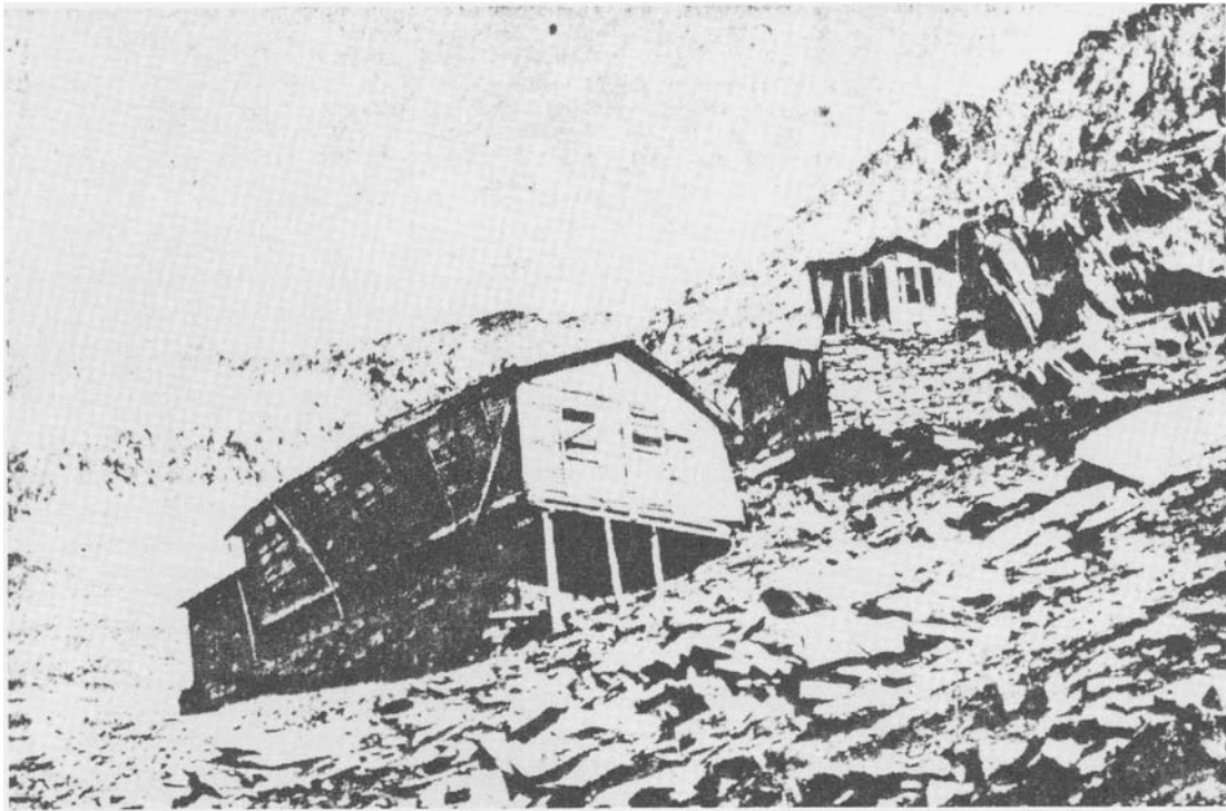
Die Baracken sind teils baufällig und erinnern an die Ruinen von Goldgräbersiedlungen.
