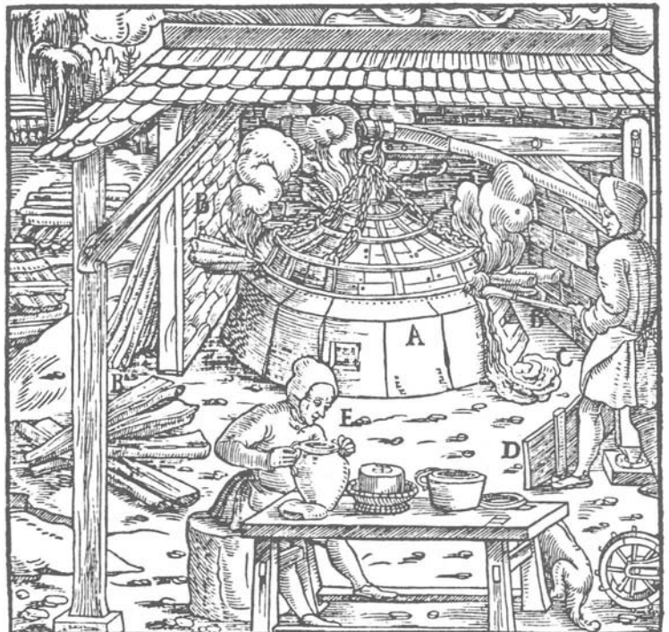
Der Ofen A. Die Holzschütte B. Die Silberglätte C. Das Blech D. Ein hungriger Meister ißt Butter, damit das Gift, welches der Herd ausatmet, ihm nicht schade; denn sie ist ein Spezialmittel dagegen E.
