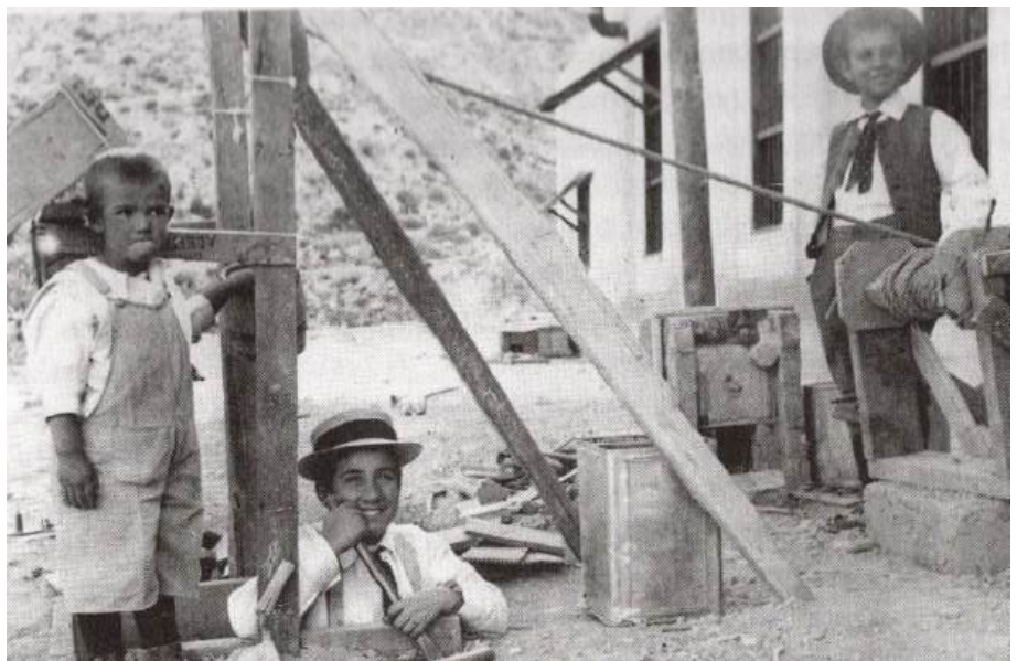
v.l. Georg, Ivan und Leonhard errichten eine eigene Mine
