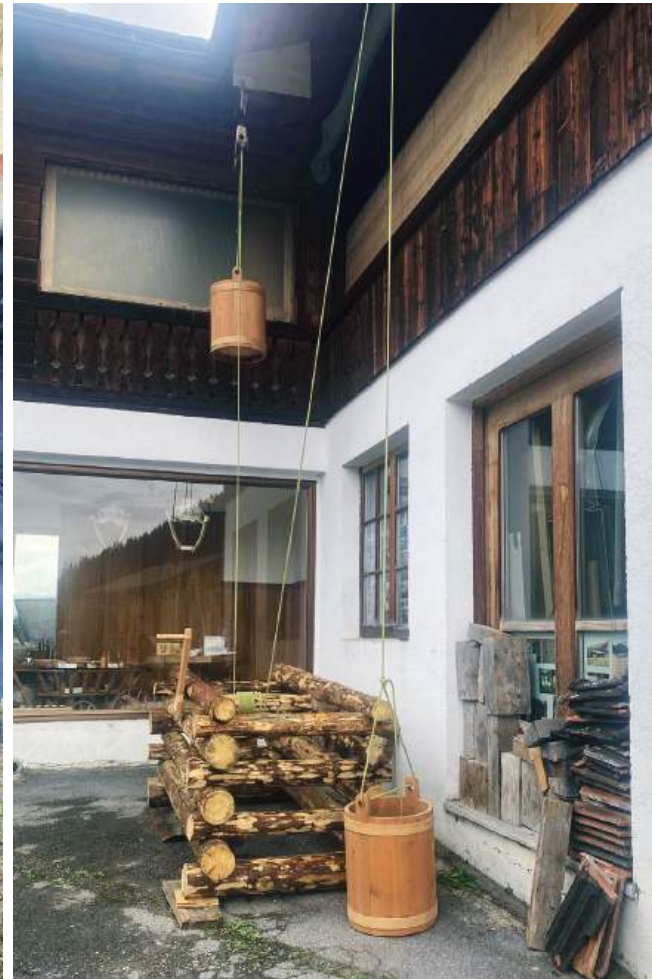
An einem alten Monsteinerhaus wurde ein bergmännischer Haspelaufzug aufgebaut.
