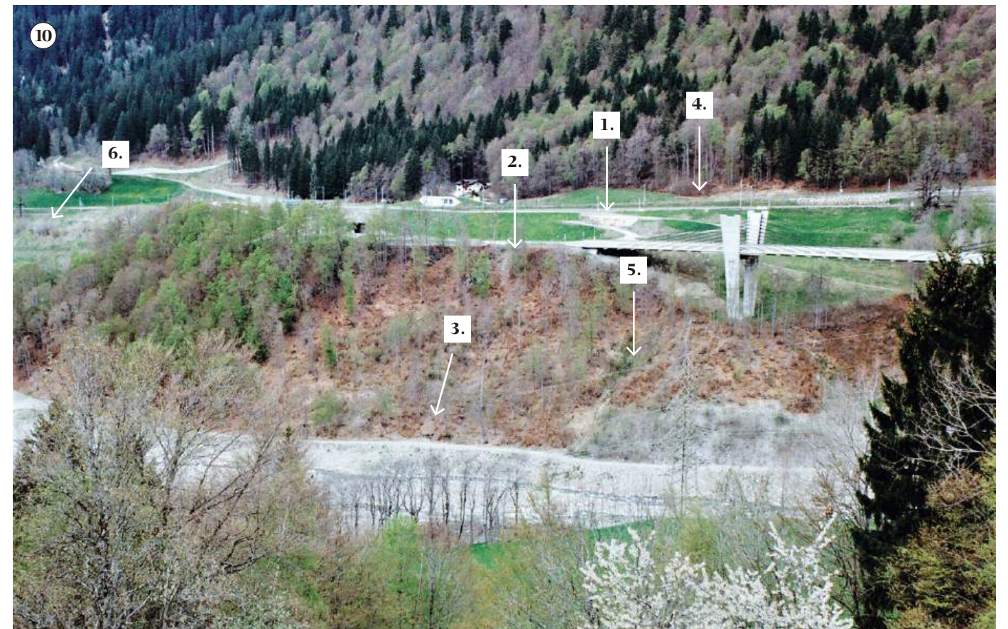
An strategisch günstiger Lage. Auf dem Geländeplateau «ufm Büel» bei Pfeil 1 liegt der vermutete Standort der Burg Badino/Padina. Pfeil 2 markiert den «Schatzstein». Pfeil 3 zeigt die Falllinie und die Fundstelle der Casanna-Eisenerzstücke am Fusse des Abhanges. Anfangs Gruobenstutz bei Pfeil 4 befindet sich das «Loch» mit dem Trockenmauerwerk und Pfeil 5 zeigt die Stelle, wo heute der Quellaustritt liegt. Ganz links aussen (Pfeil 6) liegt die Lokalität «Gruoba» mit dem ehemaligen Geheimgang (nach Lehrer Hew, 1967).
