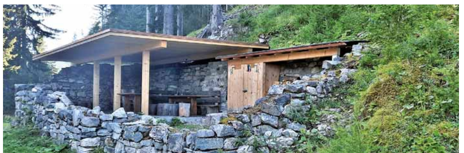
Das neue Dach des Unteren Huthauses
