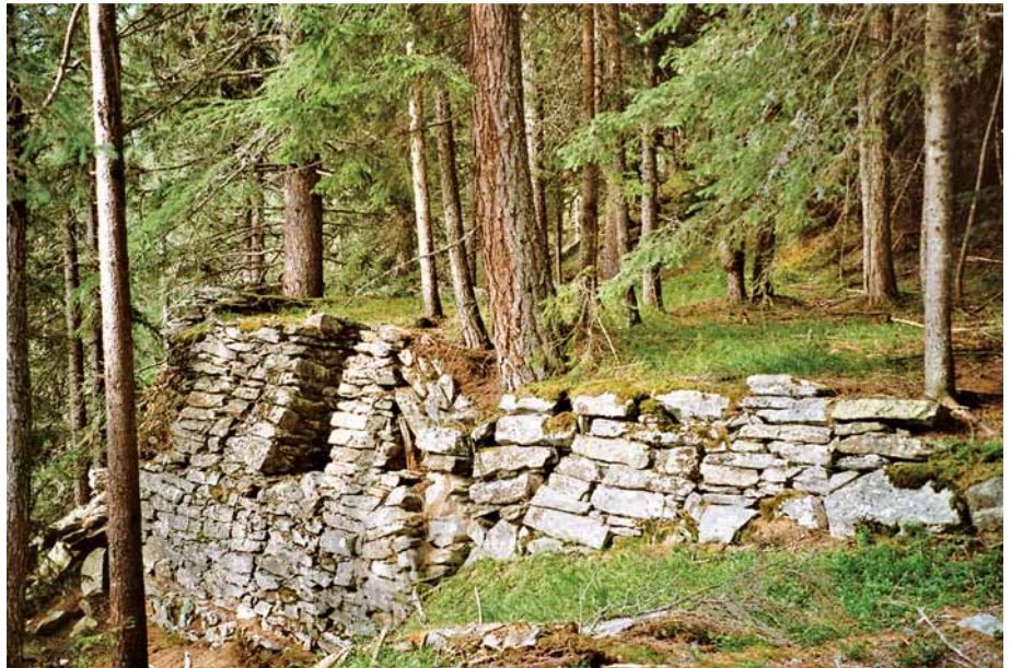
Juli 2004 vor der Sanierung
