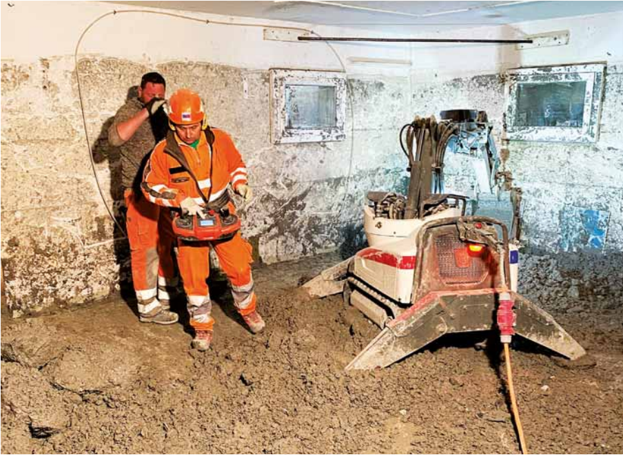
Mit einem Kleinbagger wird der Keller geräumt.
