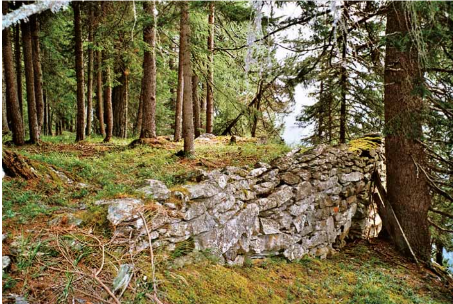
Juli 2004 vor der Sanierung
