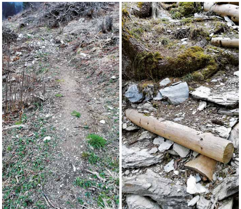
Bild 2a und 2b – Der erneuerte Zugangsweg
