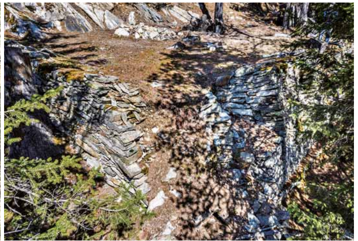
Abgestürzte Südostecke im Mai 2018
