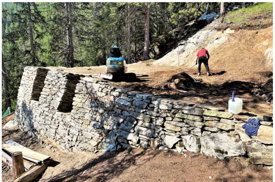
4. August 2018 nach der Sanierung
