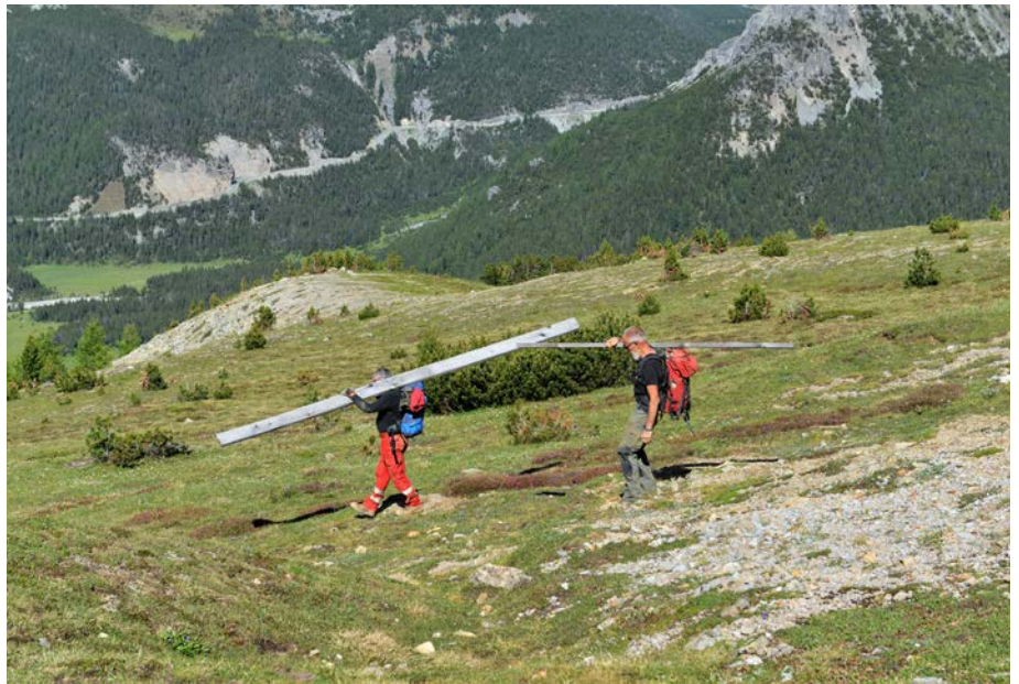
Bild 2: Baumaterial auf dem Weg zum Stollen «Zarcla»
