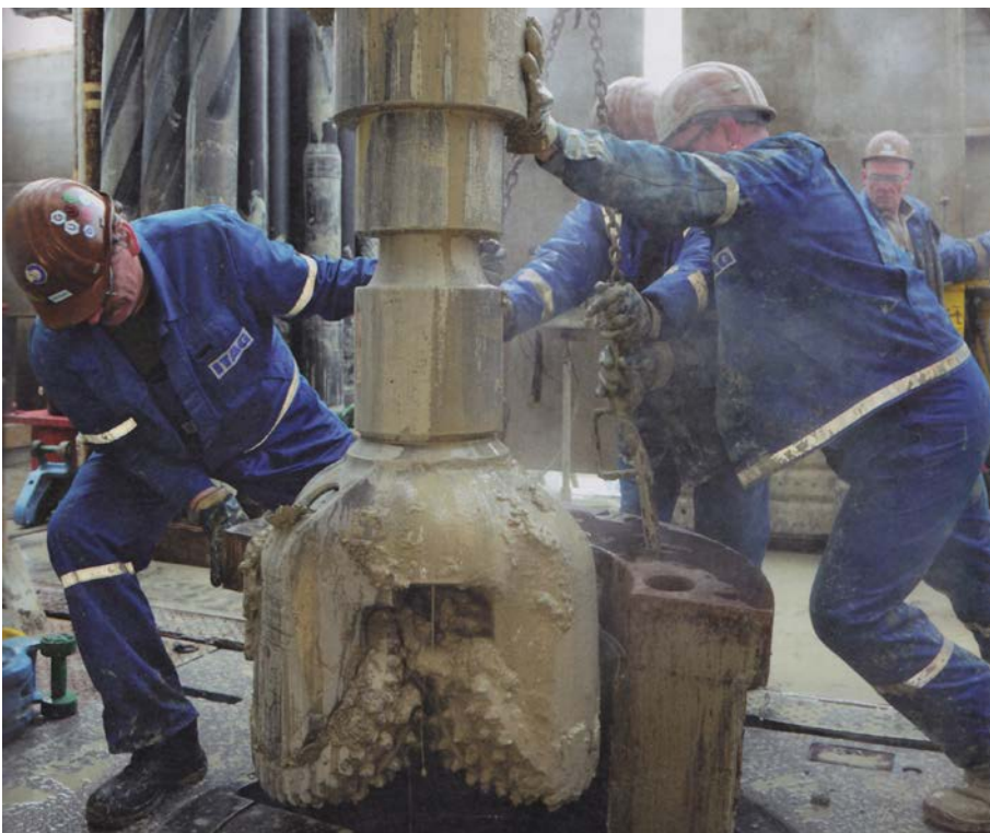
Bild 14: Positionieren des Bohrmeissels bei der Geothermie-Bohrstelle im Sittertobel.
