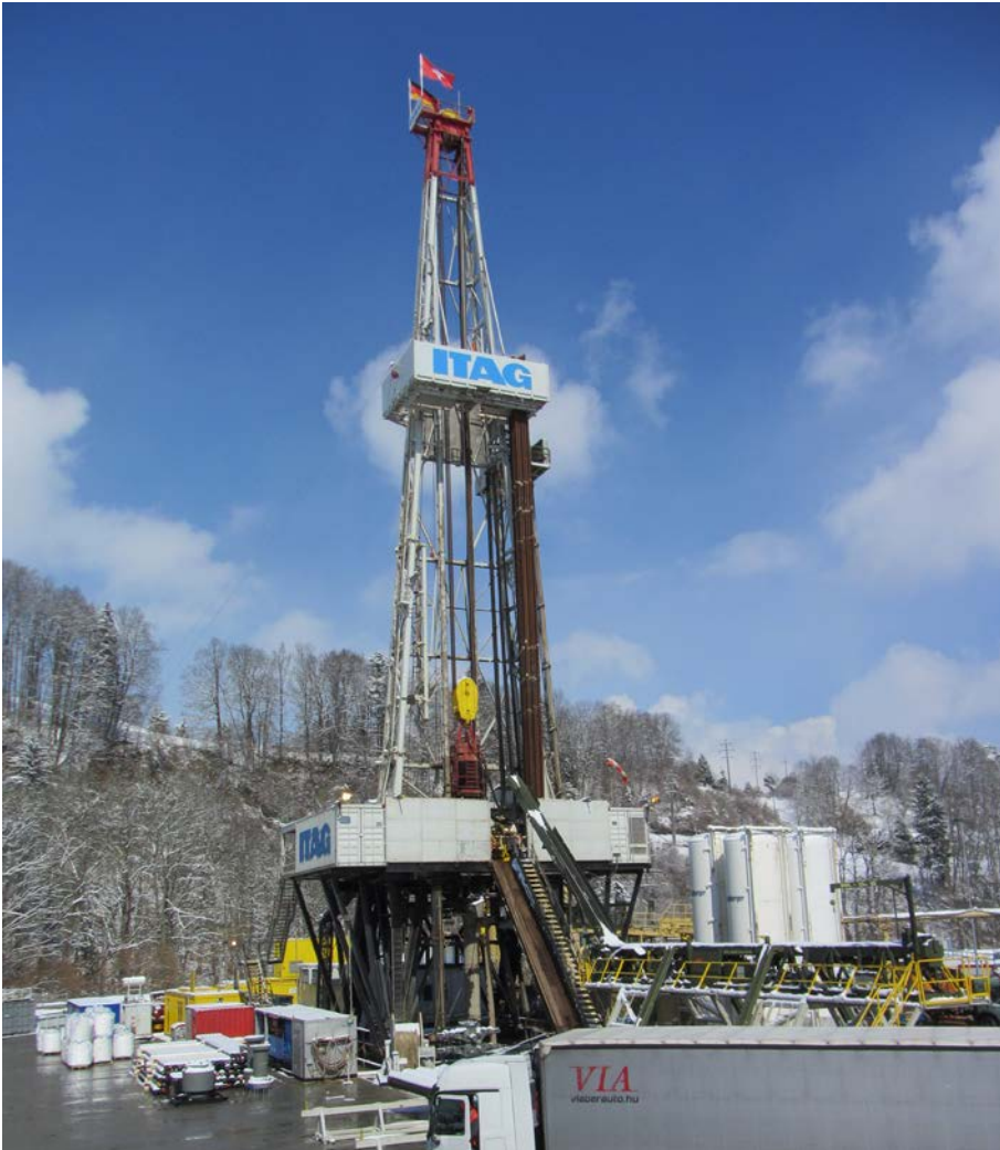
Bild 13: Der 58 m hohe Geothermie-Bohrturm im Sittertobel/St. Gallen.
