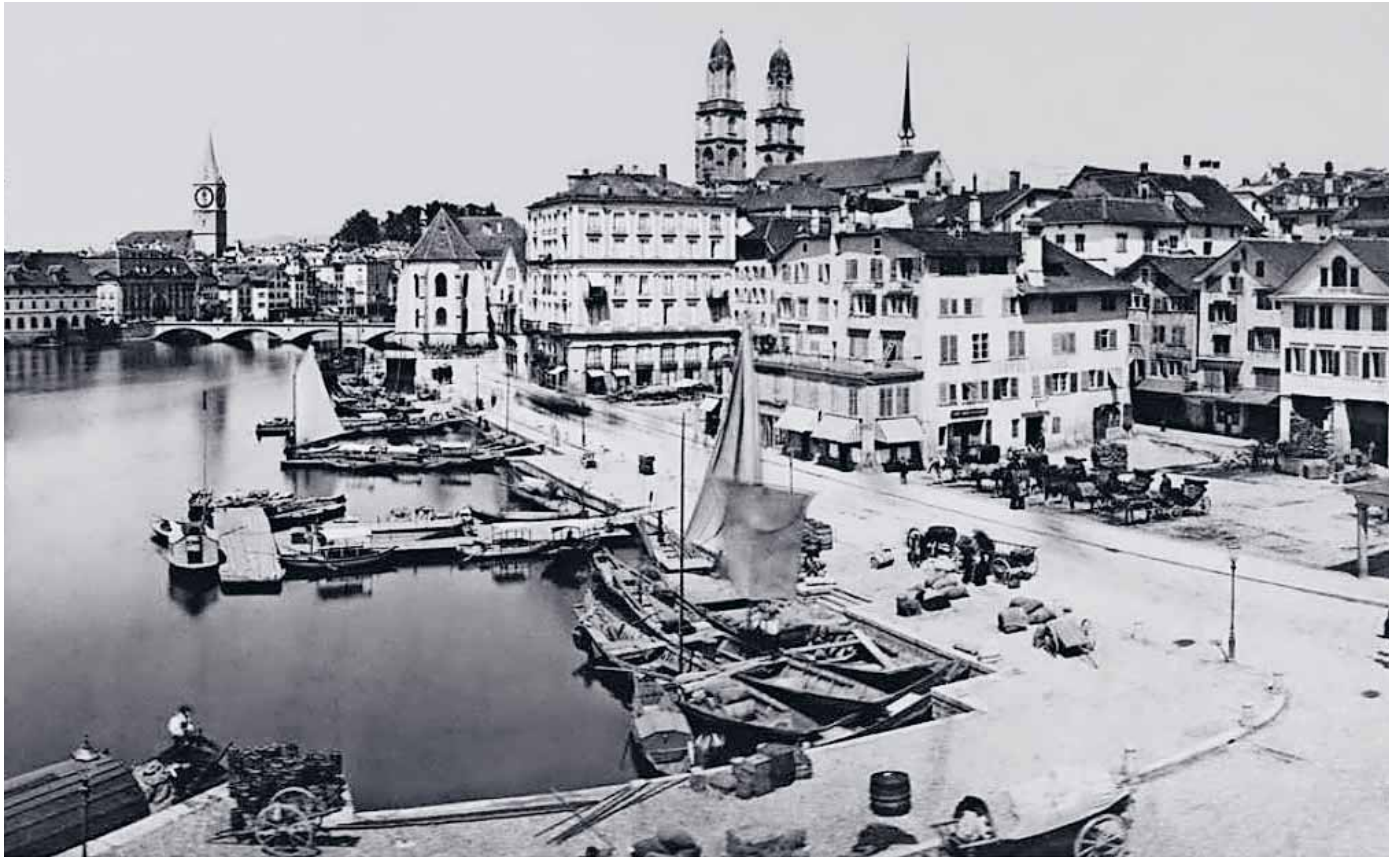
Die Schifflande in Zürich am Ende des 19. Jahrhunderts als wichtiger Umschlagplatz für Waren des täglichen Nahverkehrs und internationalen Nord-Süd-Transits (Aufnahme 1871). Lastsegelschiffe mit vorn geschlossenem Bug. Die typische Stüürtür mit Hebevorrichtung ist nicht vorhanden. (Bild zur Verfügung gestellt).
