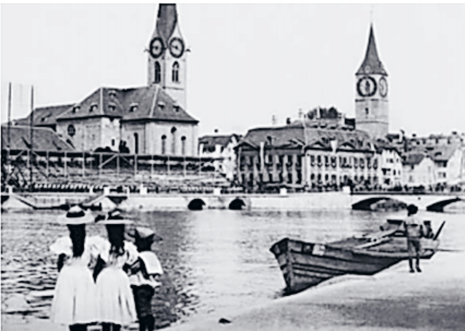
Lastschiff in der Limmat, Zürich, mit vorne spitz geschlossenem Bug (Steven) – wohl eine Innovation der zweiten Hälfte des 19. Jahrhunderts. Aufnahme von 1898 (Bild zur Verfügung gestellt)
