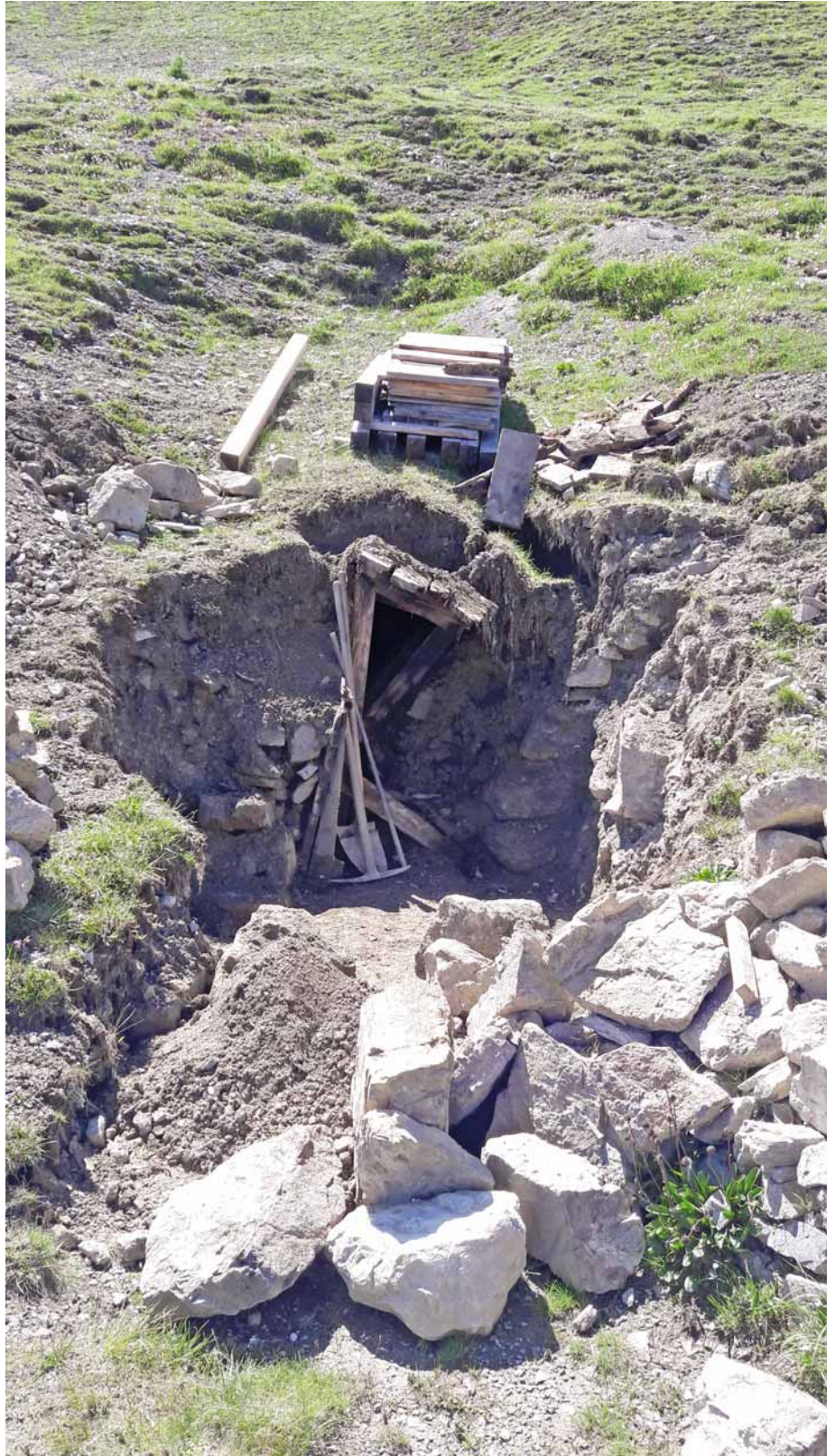
Das Mundloch des Stollens Zarcla
