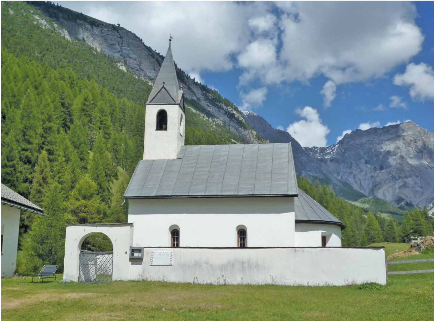
Die denkmalgeschützte und in der Bausubstanz hochmittelalterliche Kirche in S-charl.
