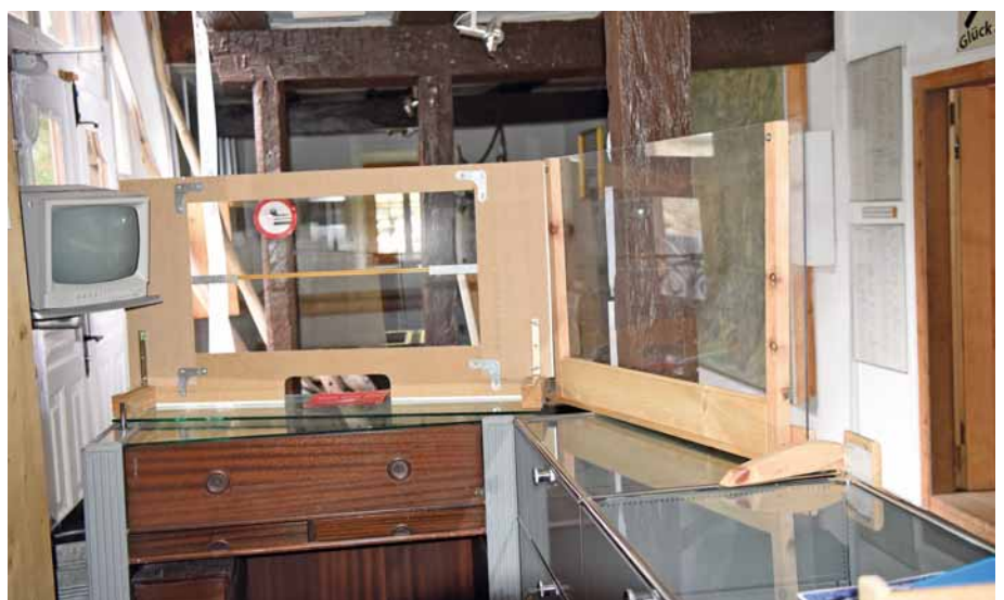
Schutzmassnahmen im Empfang
