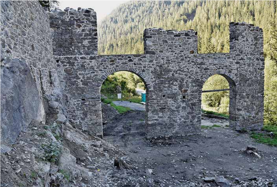
Bellaluna ohne Kran und Gerüst.
