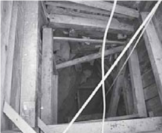
Der frisch abgeteufte Schacht zum St.-Michael-Stollen.
