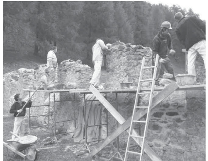
Abb. 3: Lehrlinge bei den anspruchsvollen Sanierungsarbeiten.
