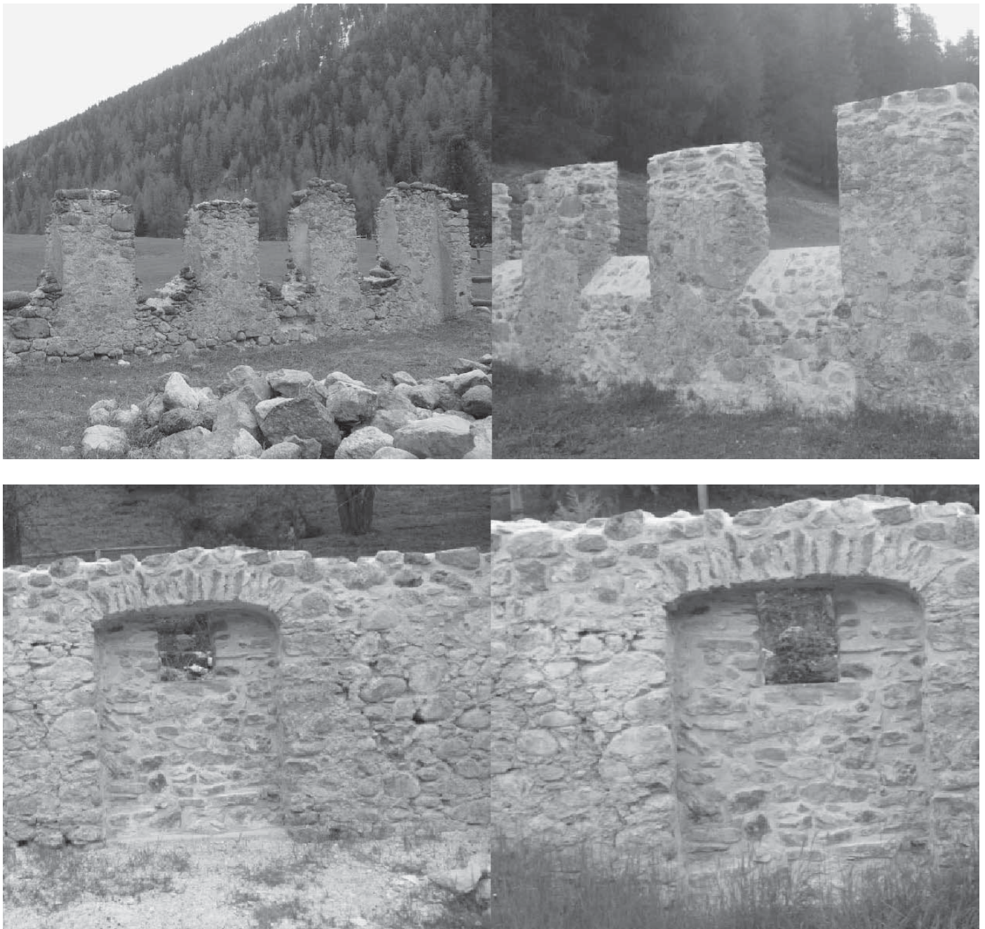
Abb. 4/5: Bilder vor und nach der intensiven Sanierung.
