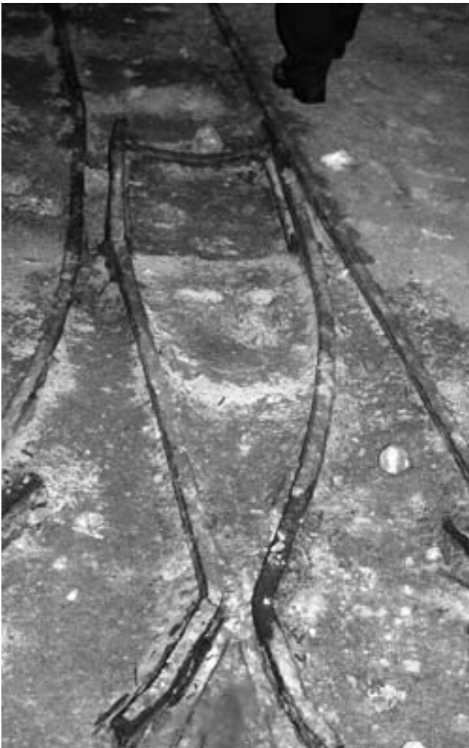
Rostig wird die Schiene, wenn der Hunt nicht drüberläuft. Hier ist allerdings der Gips schuld.
