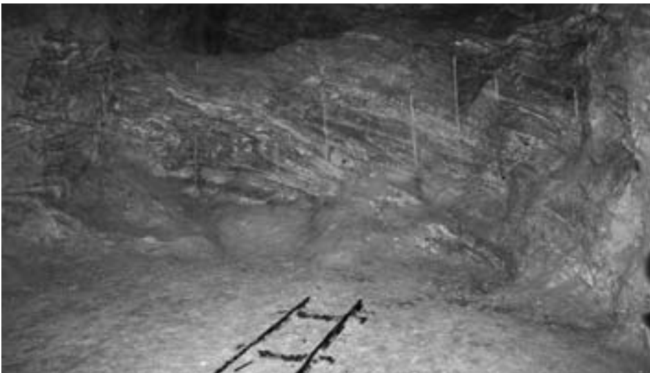
Hier wurde wie im Steinbruch von oben nach unten gesprengt.
