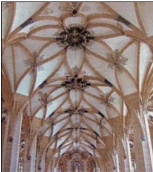
Abb. 4: Schlingrippengewölbe St. Annen.
