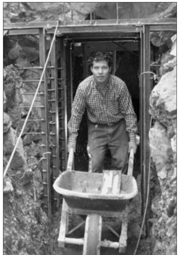
Abb. 2: Während der Sanierungsarbeiten (Bild Marianne Frei)
