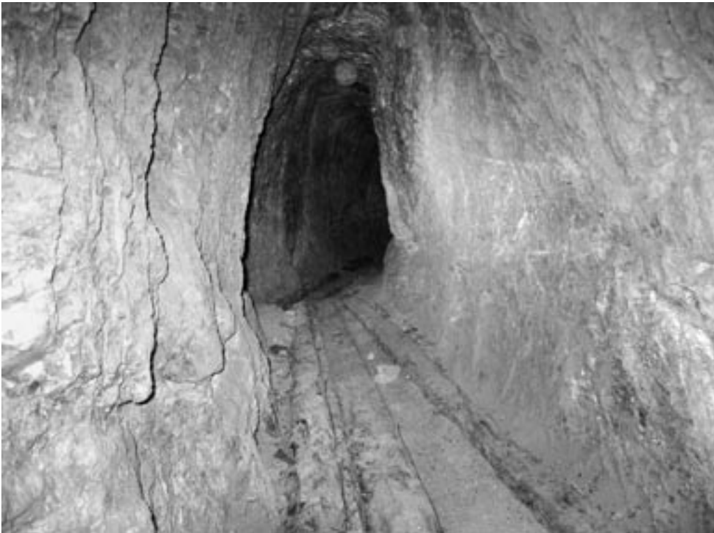
Abb. 4: Typisches Ausbruchprofil, Holzgestänge (Geleise) markieren die Förderwege (Zugangsstollen Dom).
