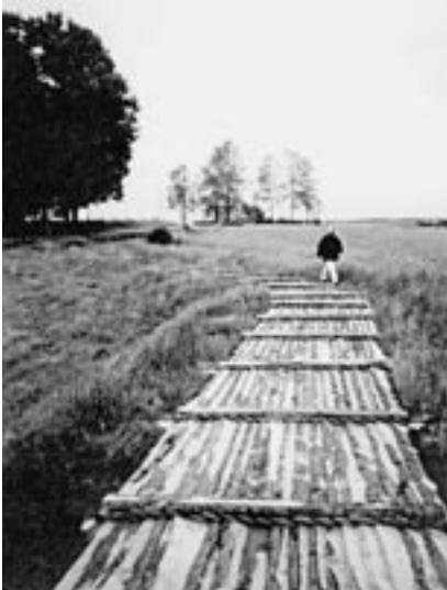
Abb. 10: Ein mit Holz abgedeckter Kunstgraben bei Freiberg. Foto H. Pforr.
