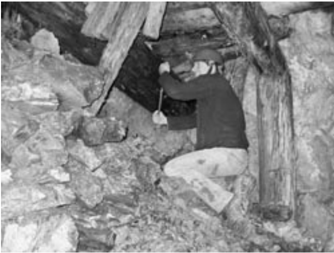
Abb. 2 und Abb. 2 a: Neuhoffnungsstollen mit Holzeinbauten am untern Ende des Schachtes der «Alten» aus dem 16. Jahrhundert.
