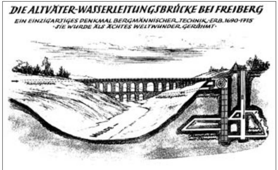
Abb. 11: Dieser Aquädukt wurde errichtet, um Aufschlagwasser eines Kunstgrabens über einen Fluss zum Bergwerk «Altväter» zu bringen.
