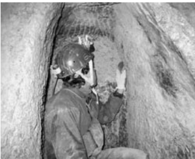
Abb. 3: Schrämspuren im Stollen Cuogn Nair.
