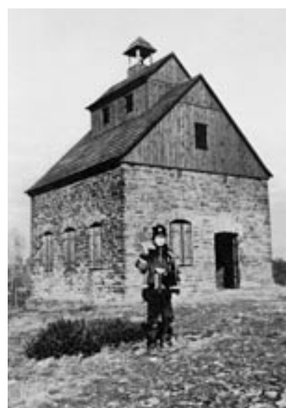
Abb. 15: Schachthaus von 1851 mit Wächterglocke zur Kontrolle eines untertägigen Wasserrads. Foto H. Pforr.
