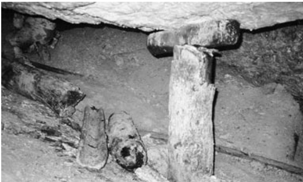
Abb. 5: Funde in einem Barbara-Seitenstollen: Stützbölzer (Stempel) und Teuchel zur Ableitung von Grubenwasser.
