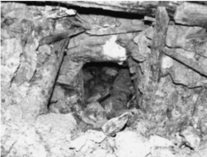
Abb. 8: Vermutete Verbindung zwischen (?) Hüttenstollen und Schacht zum Neuboffnungsstollen aus dem 16. Jahrhundert.
