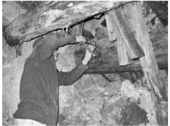
Abb. 2 und Abb. 2 a: Neuhoffnungsstollen mit Holzeinbauten am untern Ende des Schachtes der «Alten» aus dem 16. Jahrhundert.
