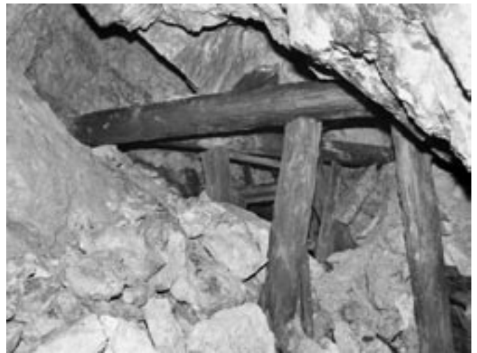
Abb. 7: Zimmerung zwischen Halle 2 und 3.
