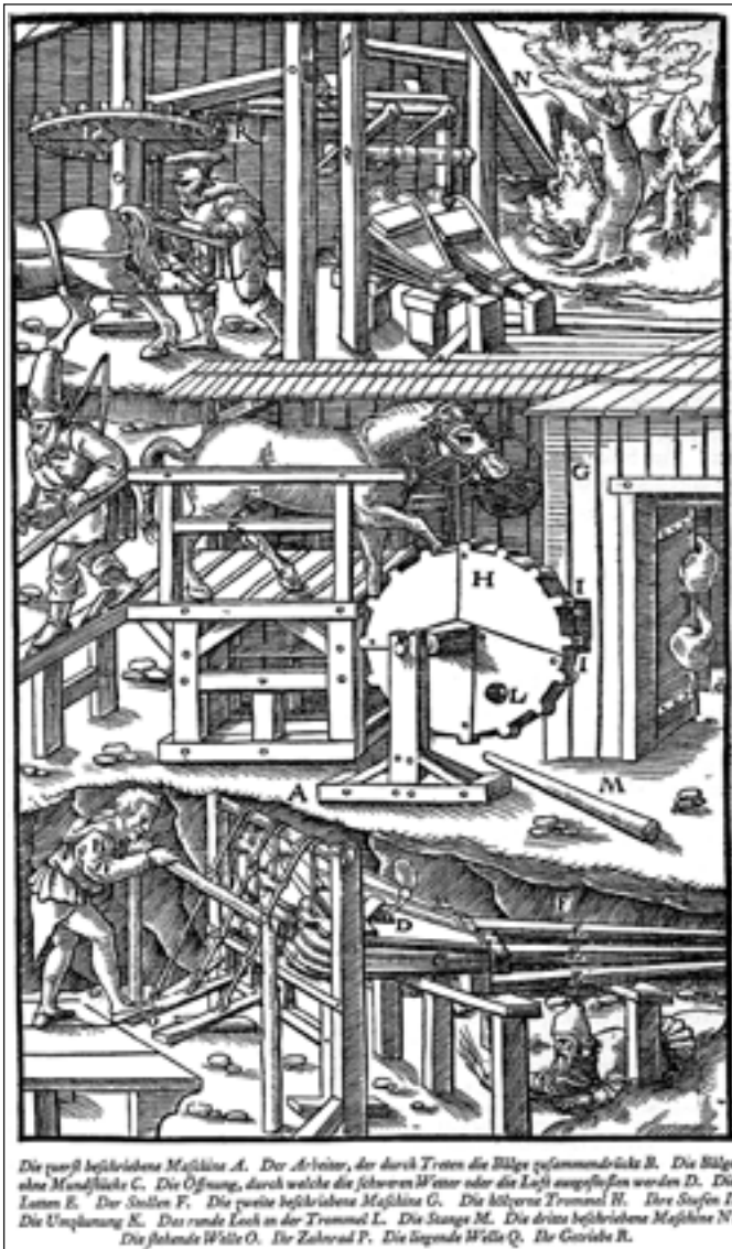
Abb. 4: Spätmittelalterliche Belüftungsmechanik für den Bergbau. Aus [1].
