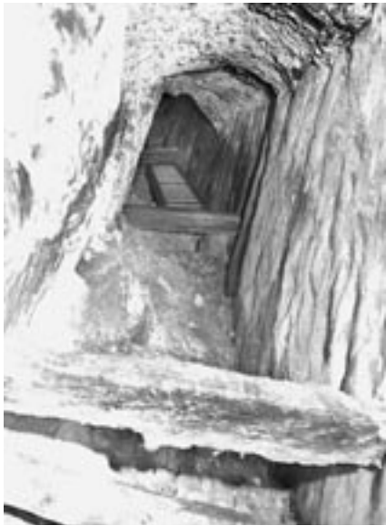
Abb. 10: Blick vom Vorstollen in den Sondierschacht; sichtbar sind die Querhölzer für die Leitern bei 4 m und 8 m.
