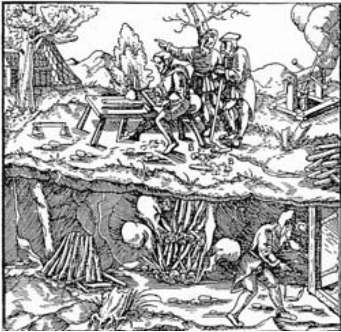
Abb. 7: Feuersetzen zum Mürbemachen des Gesteins nach Agricola, 1556.
