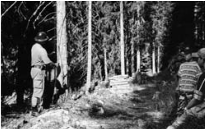
Bild 4: Hegerodung auf dem Rollbahn-Trasse: Eine abgestorbene Fichte wird vom Verfasser zum Fällen vorbereitet. Zur Vermeidung des Hängenbleibens in benachbarten Baumkronen wird vor dem Fällen ein Seilzug angebracht und der Baum anschliessend mit Vorspannung gefällt. Lloyd und Sidney Beeler beobachten aufmerksam die Szenerie.
