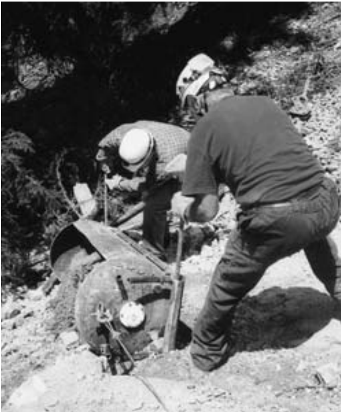
Abb. 1.7. \frac{1}{4} m 3 Versturzmateriel findet einen neuen Lagerplatz.
