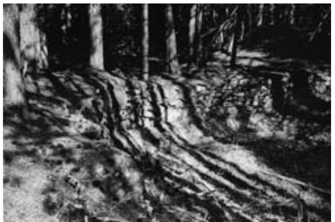
Bild 2: Ausgangssituation im Ostteil des Rollbahn-Trassees: Dichter Baumbestand etablierte sich während der vergangenen 125 Jahre auf dem Trockensteingemäuer (die Bestockung auf dem Trassee setzte etwa 1880 ein, siehe letztes Kapitel). Besonders bei Sturmwinden entfaltete dessen Wurzelwerk zunehmende destruktive Zugkräfte am sensiblen Gemäuer, welches für grosse Bäume eine denkbar ungünstige Unterlage bildet.
