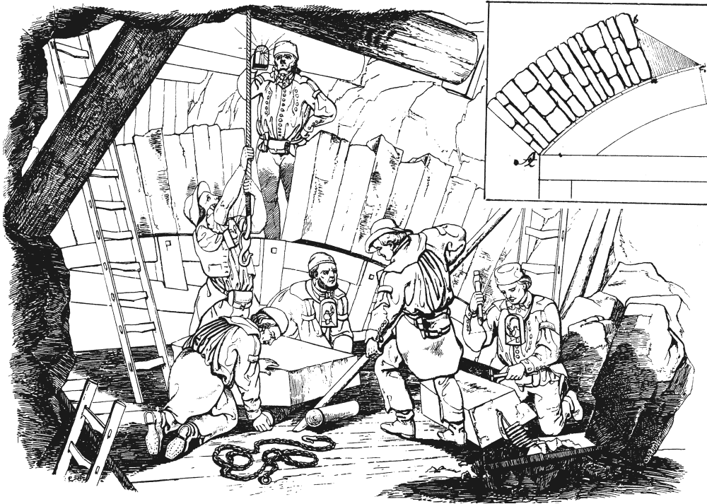
Abb. 15 Im 18./19. Jahrhundert wurden die Freiburger Stollen und Strecken mit Firstgewölbemauerung versehen, eine schwere Arbeit, die hier von Eduard Heuchler (1857) dokumentiert wird
