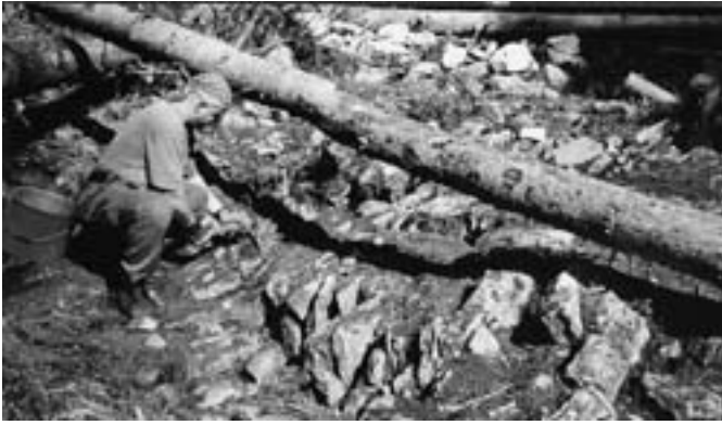
Bild 9: Freilegung einer bereits vor langer Zeit umgekippten, aber noch im intakten Mauerverband erhaltenen Gebäudewand des östlichen Knappenhauses: Der Verfasser beim umsichtigen Entfernen von Wurzelbewuchs aus den Mauerfugen.
