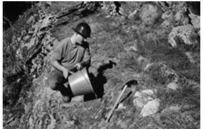
Bild 13: Pflege des Rollbahn-Trassees: Regenauswaschungen und teilweise tiefe Hohlräume werden mit zahlreichen Kübelladungen Steinen, Split und Erde wieder ausgefüllt und festgestampft.
