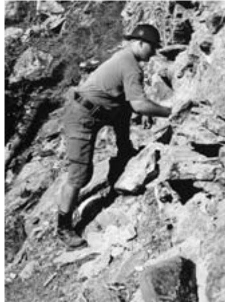
Bild 12: Pflege des Rollbahn-Trassees: Herausgefallene und abgerutschte Steinblöcke im stellenweise mächtigen Trockenstein-aufbau werden vom Verfasser wieder in Position gebracht.
