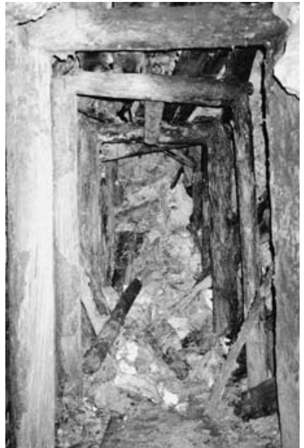
Abb. 1.9. Im Bereich dieses Versturzes vermuten wir das Baumannlager.
