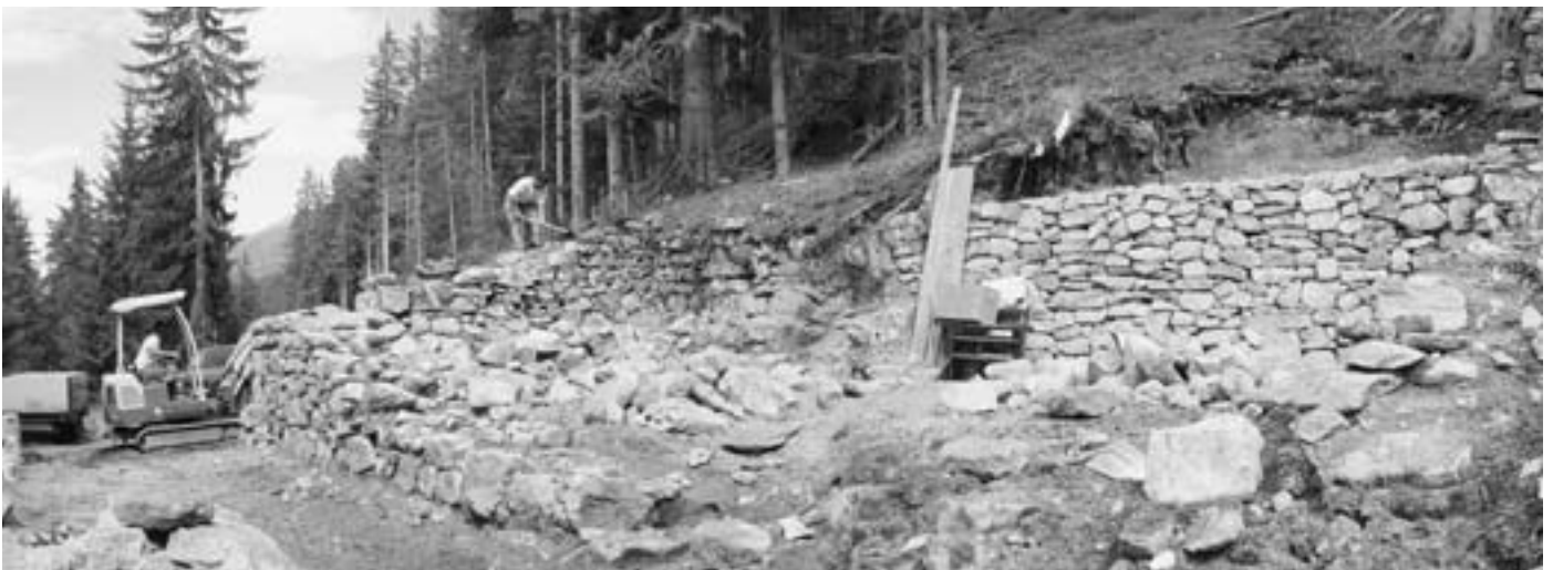
Abb. 2.4 Ausgrabungs- und Restaurierungsarbeiten am Restmauerwerk. (Fotos 2.1 bis 2.4 von Marianne Frey Hauser).
