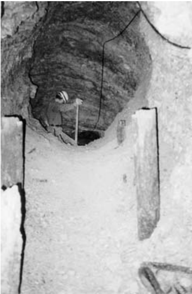
Abb. 1.3 Ein grosser Teil der Versturzmasse ist abgetragen. Die vertikalen Pfosten sind ungefähr 2 m lang und gehören zur eingedrückten Türstockzimmerung.
