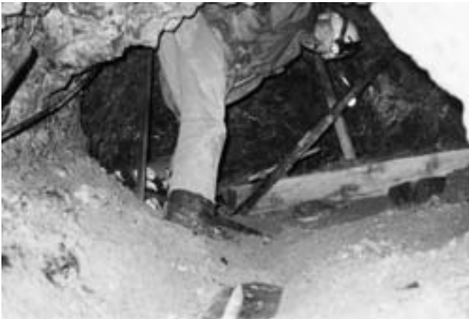
Abb. 1.2 Der zweite Versturz ist 4-5 m hoch und befindet sich 100 m vom Mundloch entfernt.
