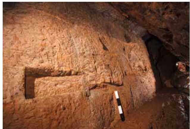
Nachrissarbeiten durch Schiessen unter Verwendung eines Schiessblechs im Weisstauber Stolln; Bohrloch-nischen: 20 x 50 cm, Bohrlochlänge: 80 cm, Durchmesser der Kolbenbohrer: 5 cm. Foto: Kugler, J.; 2015
