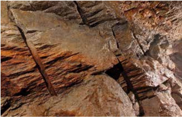
Bohrlochspuren (Ø 5 cm) von Kolbenbohrern. Foto: Kugler, J.; 2011
