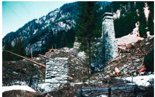
Abb. 33: Schmelze Ausserferrera nach Lawinen-niedergang Frühjahr 1975. Die Situation spricht für die Stabilität des um 1860 erstellten Mauerwerks. Blick gegen N.
