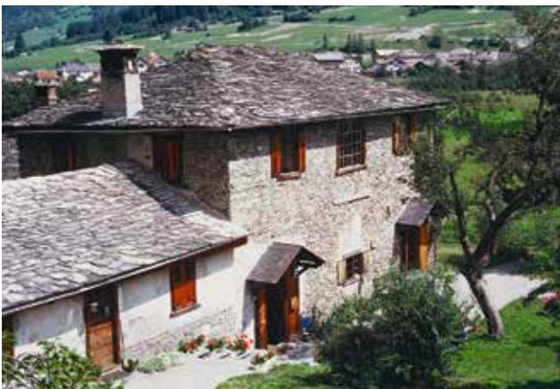
Abb. 26: Südfront des Blashochofens Rosales in Andeer. Unterhalb des mittleren Fensters im zweiten Geschoss ist die Widerlagerplatte für die Gichtbühnenrampe sichtbar.
