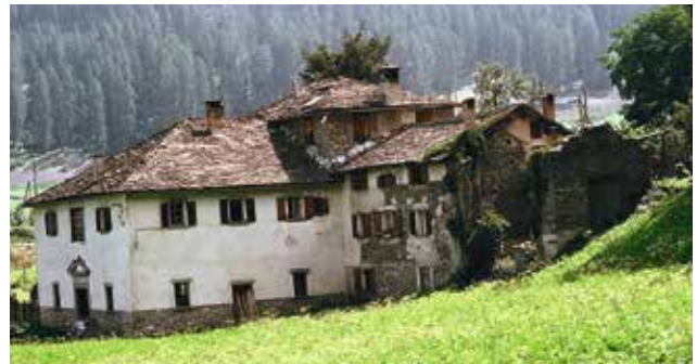
Abb. 41: Westseite des Hauses Rosales. Im höchsten Gebäudeteil im Zentrum befindet sich der Hochofen.
