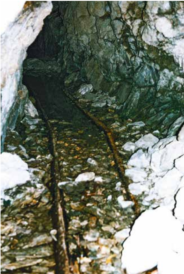
Abb. 17: Holzschiene der englischen Gesellschaft «Val Sassam Mines Company» im Rebassostollen in Ursera aus dem Jahre 1865.
