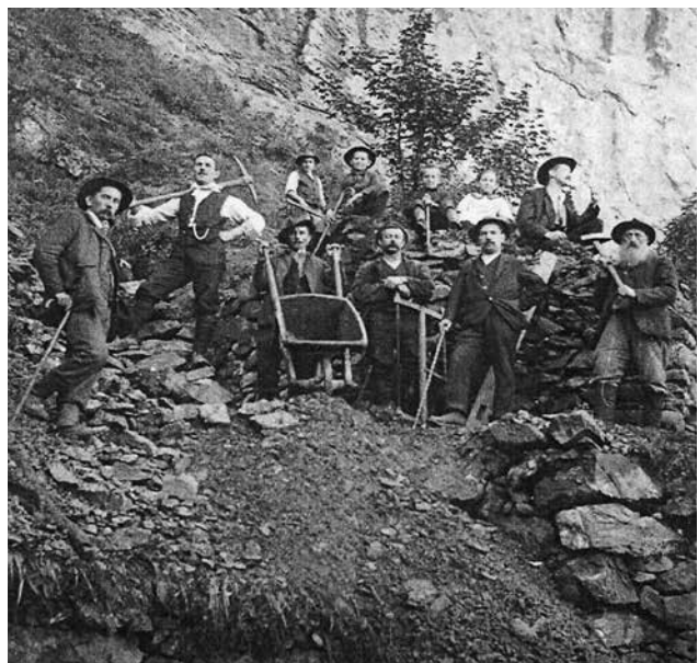
Arbeiten über Tage.
