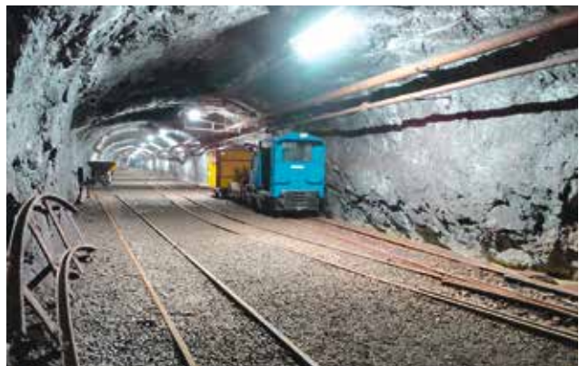
Fahrt in den Basisstollen.
