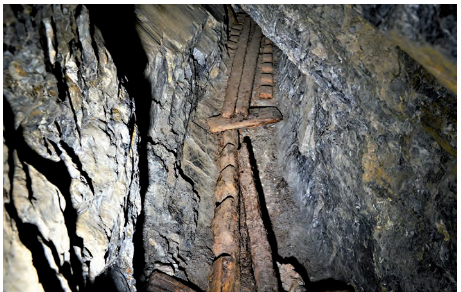
Neben der Laufplanke eingebauter Steigbaum, Stollen «Zarcla», Buffalora
