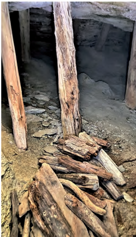
Cava da Mettal: Gut erhaltener Holzeinbau im trockenen Stollen
