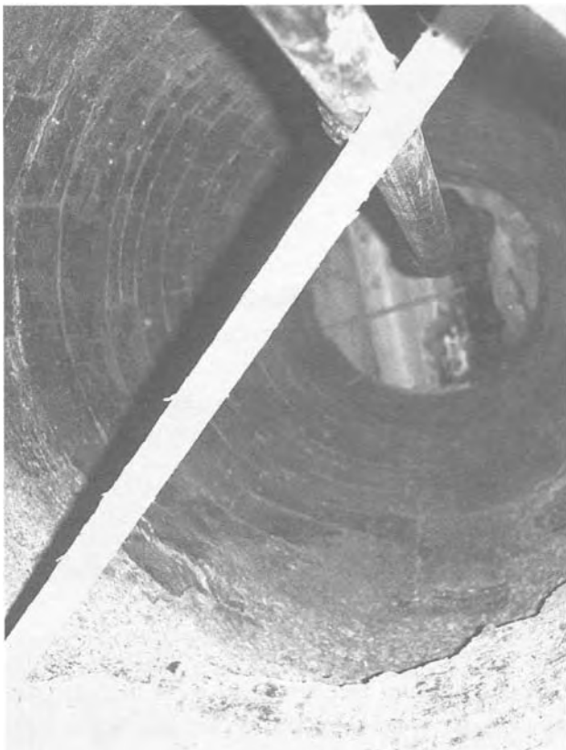
Oben: Blick von der Abstichöffnung durch den Ofenschacht nach oben. Rechts: Gichtbühnen
