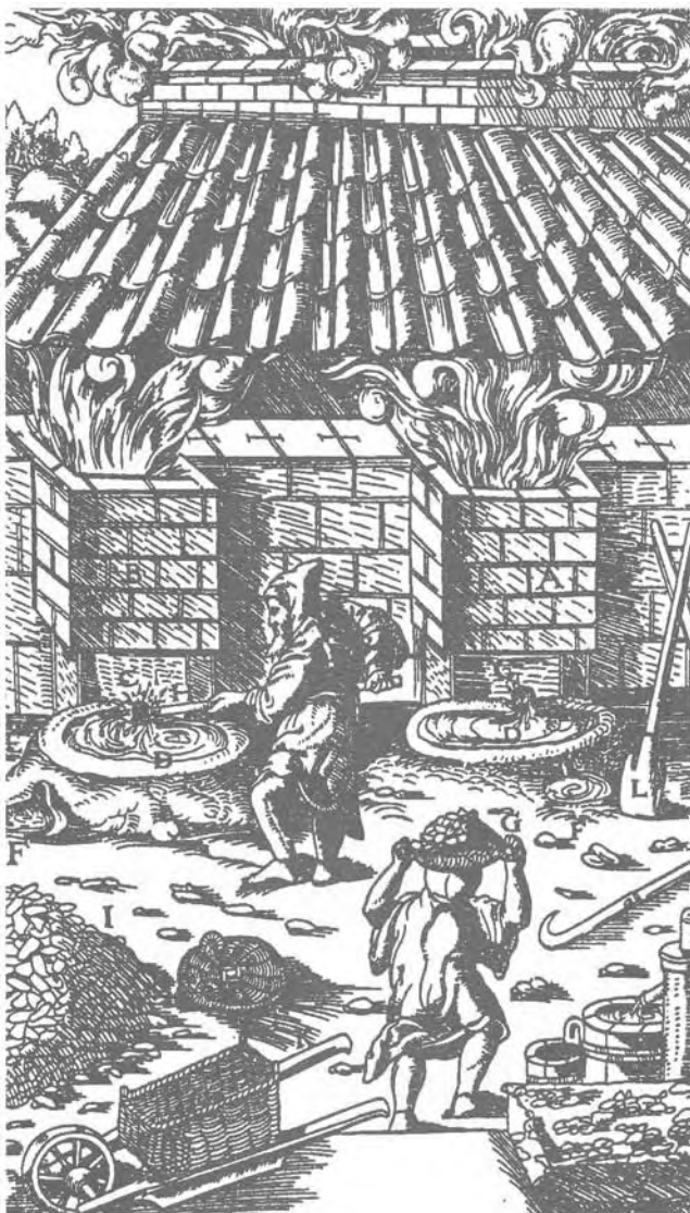
Bleischmelzofen nach Agricola 1556
