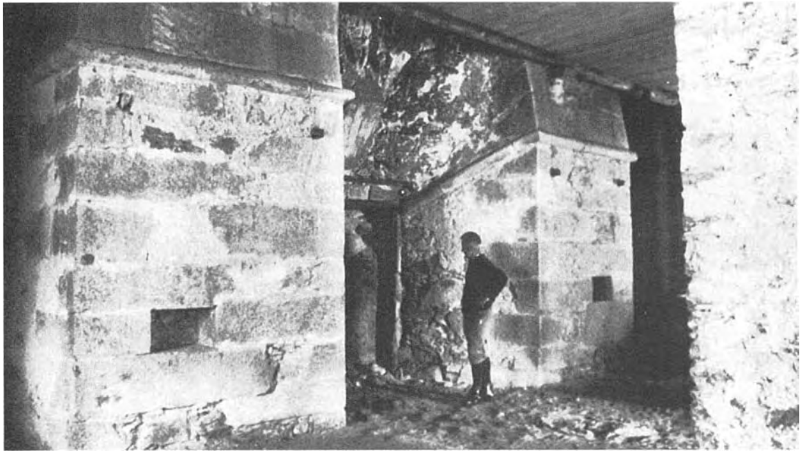
Abstichöffnung des Blashochofens.
