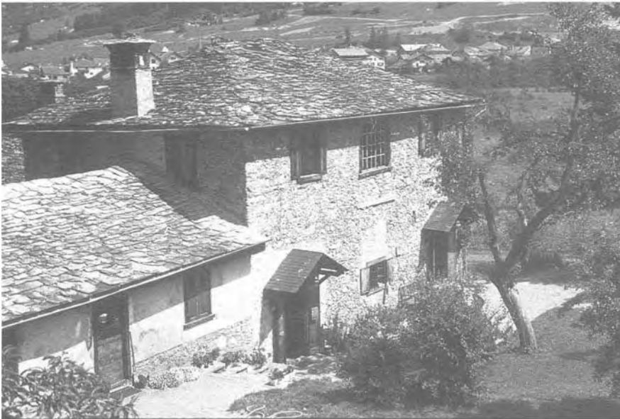
Südfront des Hauses Rosales. Unterhalb des mittleren Fensters im zweiten Geschoss ist die Wi- derlagerplatte für die Gichtbüh- nenrampe sichtbar.
