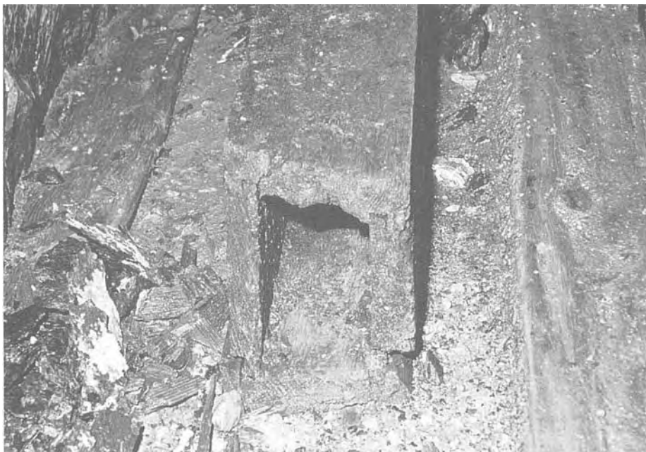
Tüchel als Wasserleitung von herabstürzendem Gestein aufgebrochen
