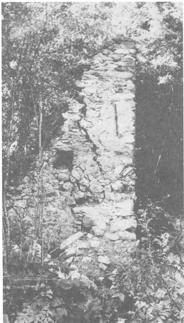
Der vom Zerfall bedrohte untere Schmelzofen
