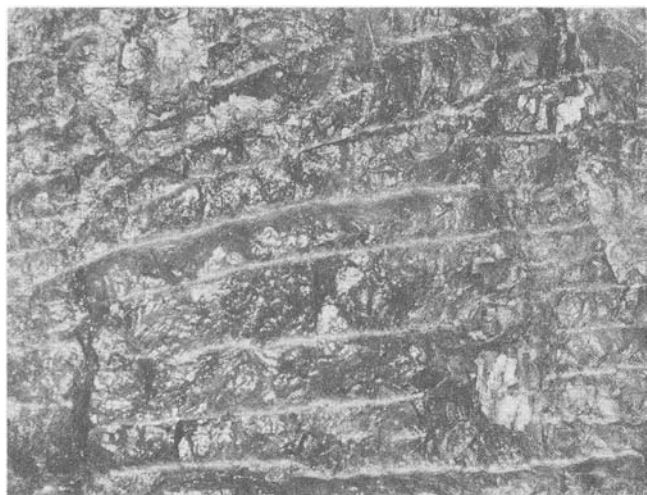
Stollenwand mit Schrämmspuren
