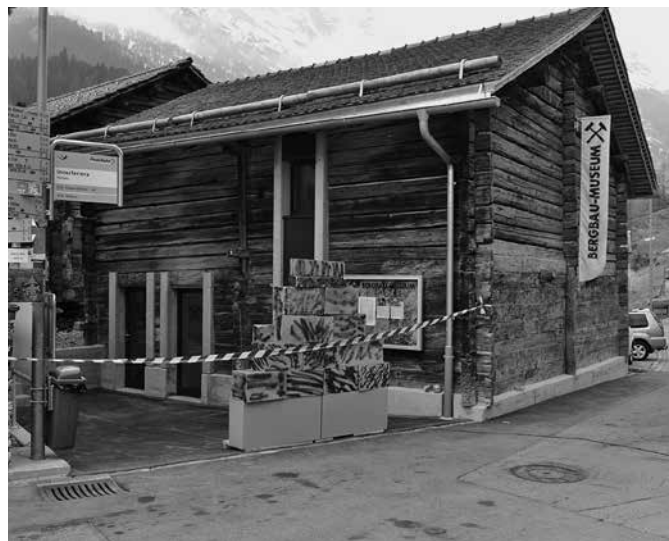
Noch steht die Mauer. Gleich folgt der Schuss. (Foto E. Rehm)
