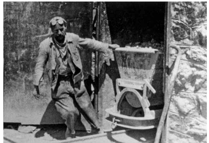
Der gebrannte Kalk wird im Rolli (Lore) unten aus dem Ofen gezogen.
