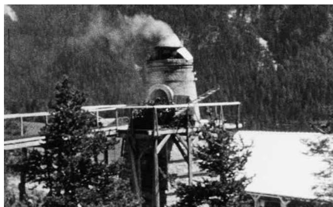
Der Kalkofen im Betrieb, Sicht vom Steinbruch her. Auf der Plattform ein Zwischenlager für Koks.
