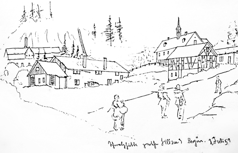
Bellaluna im Juli 1859, eine eindruckliche Industrieanlage: Das Direktionsgebäude mit dem Türmchen rechts steht noch heute, vom Hochofengebäude hinten links sind noch die markten Mauerpfeiler, die beiden Rennfeuergruben und die Stützmauern erhalten.
