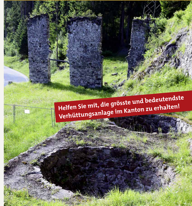
Die markanten Mauerpfeiler des ehemaligen Hochofengebäudes Bellaluna in Filisur sind einsturzgefährdet und müssen dringend saniert werden.
